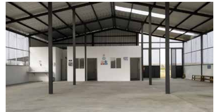
El proyecto EXPORT-DES, con el componente calidad, aportó en la construcción de infraestructura de la empresa.
